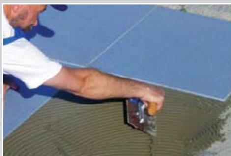
Укладка крупноформатной плитки на клей SUPERFLEX K77
