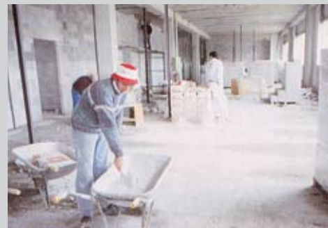
Приготовление раствора ВЕТОНКОЛ К9
